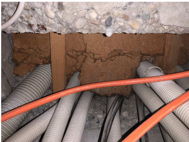
Obr. 5: Požiarne utesnenie medzi poschodiami
