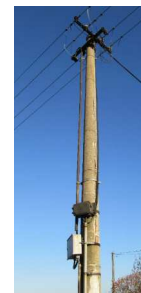
Obr. 3: Přípojka z venkovního vedení provedená kabelem
