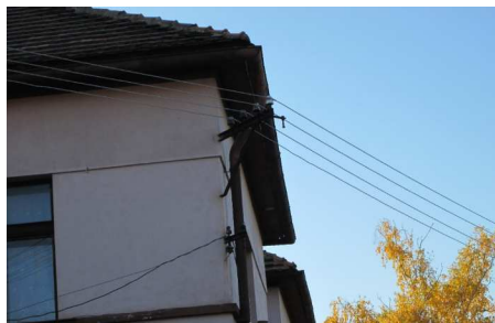
Obr. 2: Přípojka provedená z venkovního vedení na konzole
