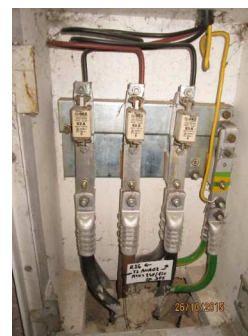
Obr. 6: Reálná fotografie vnitřku HDS
